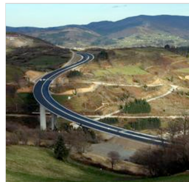
Algunos trabajos en el tramo están ya muy adelantados. /A. FERNÁNDEZ
