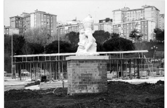
Se está construyendo una marquesina para el autobús. / SANE
