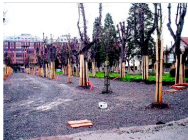
Los trabajos de remodelación del parque de Cupido permanecen suspendidos desde diciembre. / JAVIER
