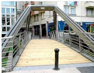
Imagen de la pasarela. / JAVIER
