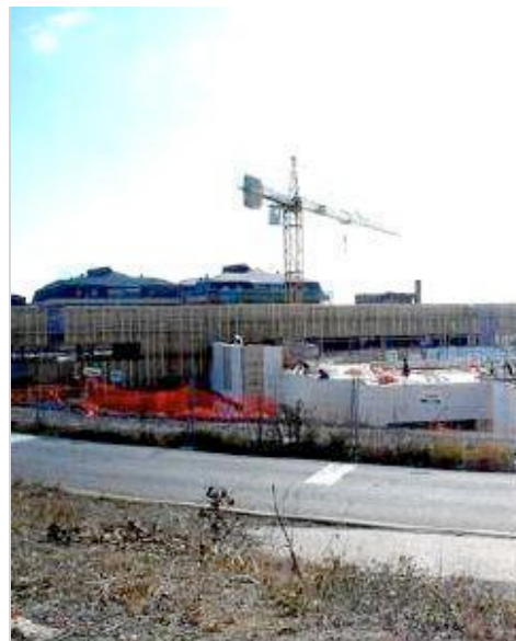
Obras del Hospital Tres Mares en Reinosa. / JAVIER DÍAZ
