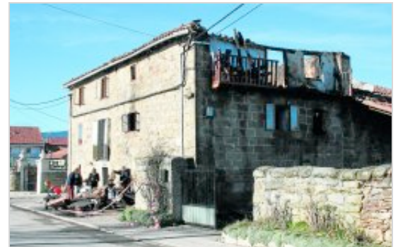
Los servicios de emergencias sólo pudieron salvar la primera planta de la casa. / J.L. SARDINA
