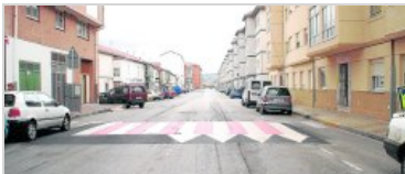
En la Avenida de La Naval se llevará a cabo la renovación de la red de saneamiento. /JAVIER
