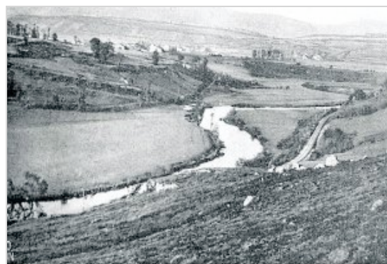
La ladera izquierda del Ebro antes de la obra. Al fondo, La Lastra. / DM
