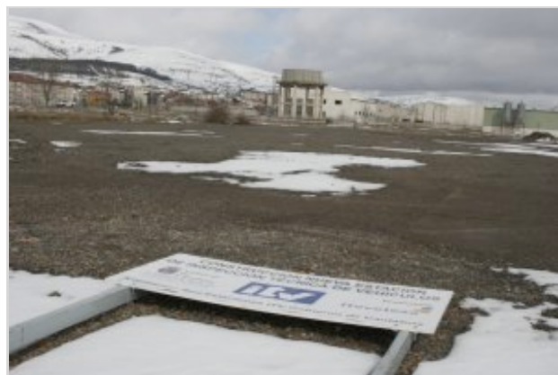
Las obras de la planta de ITV, en el polígono de La Vega, están paradas este mes por el mal tiempo. :: E. S.
