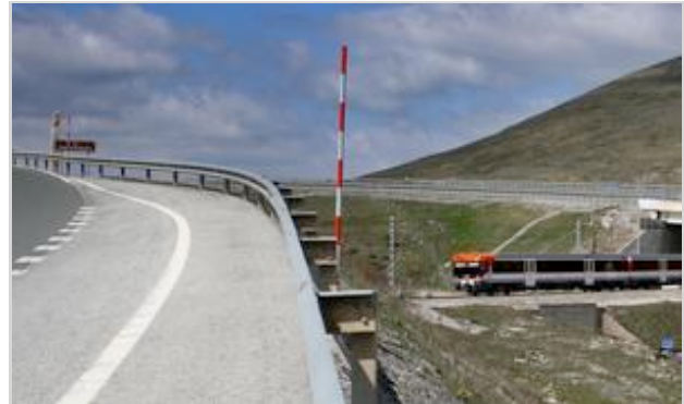
El trazado atraviesa algunos pasos complicados, como el que muestra la foto. A la izquierda, la N-611. A la derecha, la CA-741, dirección Polientes. En el centro, la vía de RENFE y, sobre ella, la autovía A-67. El nuevo trazado de alta velocidad atravesará con un túnel de 3 kilómetros el monte Matanzas, que se aprecia al fondo. :: JOSÉ LUIS SARDINA
