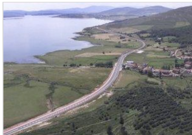
Vista de la carretera de Corconte, en cuya vertiente norte estaba prevista la Autovía. :: ANDRÉS FERNÁNDEZ
