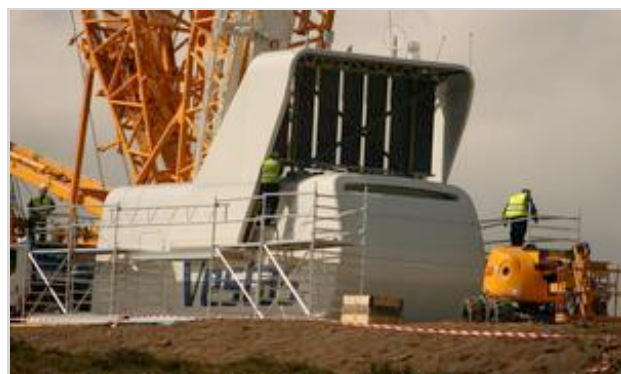
La góndola del aerogenerador, que incluye la turbina de 3 megavatios, antes de ser izada. :: J. L. SARDINA
