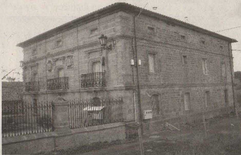
Ayuntamiento de Arija, actualmente en obras.
