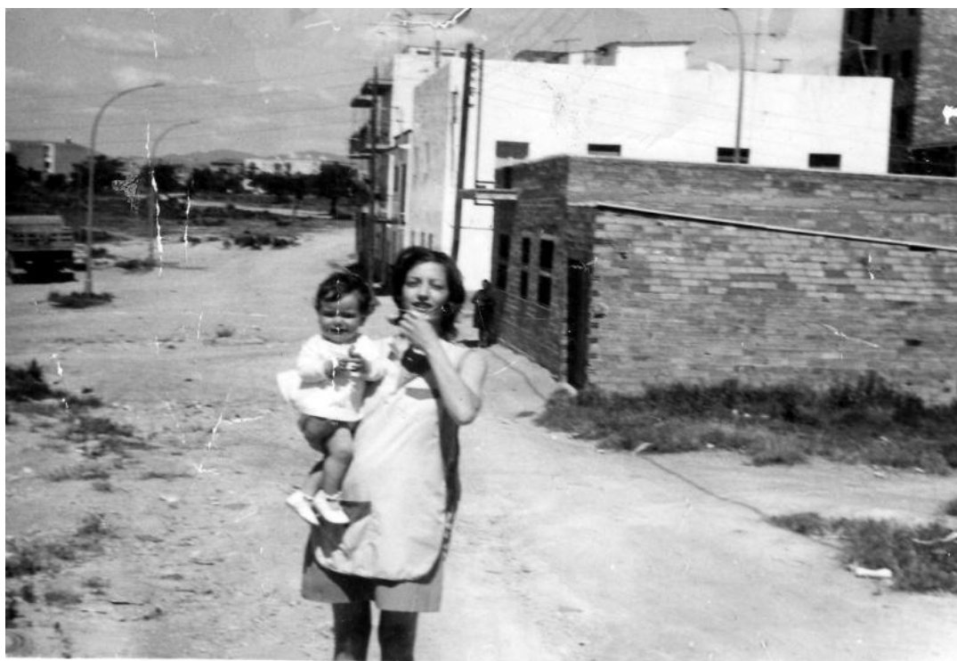
El barrio crecía lentamente; este era el estado de la calle 3.
