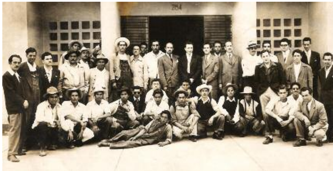
Azorín (junto a la columna de la derecha) con un grupo de trabajadores en una obra en 1945 en México. Archivo Azorín
